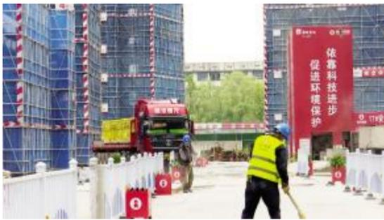
还能减少工地尘土对周边的影响,蓝色的安全网将建筑物包裹得严严实实,脚手架一周还装有喷雾系统,喷头距离都严格控制在2米以内,有效防止施工扬尘外溢。
