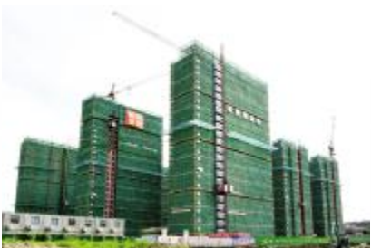
华润置地杨家门商住办项目封顶
