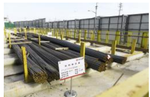
钢筋材料堆场
