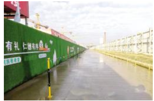
施工区围墙及道路硬化
