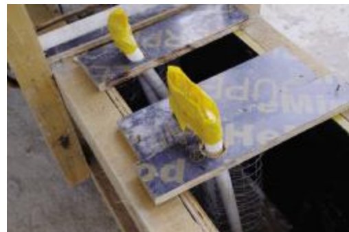
预埋管定位及管道防开裂钢丝保护
