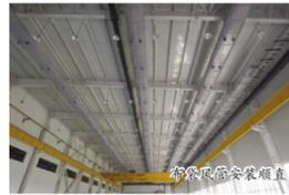
厂房顶部,替代了传统送风管道、风阀、散流器、风口等各种部件、配件的功能。金属灰的颜色与整个空间格调保持一致,高档简约;金属风管采用共板法兰连接,安装平直;强弱电布线桥架、吊架和防晃支架安装规范,支架水平标高一致;消防管道巧妙地安装在了一侧的墙面上,节省了顶部的空间,配合侧面的X型楼梯,便于维护。在一片灰金属色中,双梁起重机及其轨道的黄色给色彩单一的厂房增添了一抹亮色。
