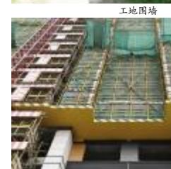
悬挑架体底封闭
