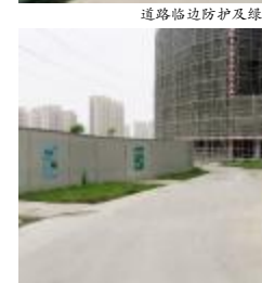
施工道路硬化
