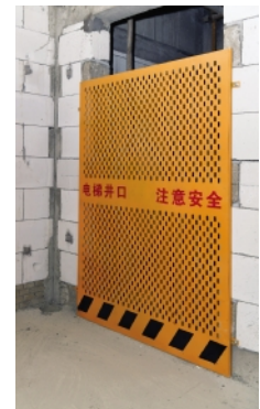
电梯井口防护
