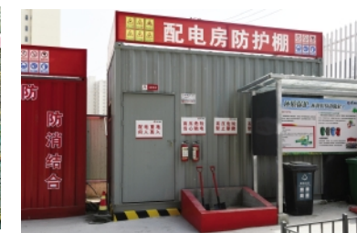
配电房防护棚
