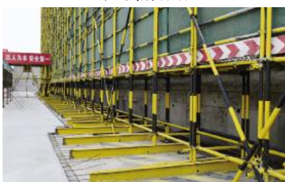
脚手架立杆基础
