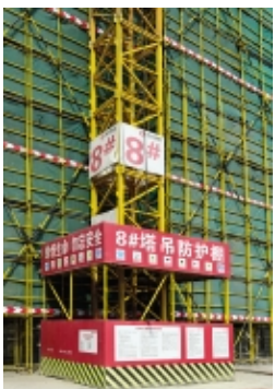
塔吊基础防护
