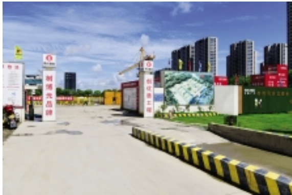
施工区入口大门
