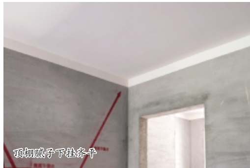
楼地面浇筑前完成墙面粉刷
