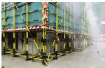
脚手架基础、架体设喷淋
