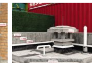
屋面防水和出屋面结构工艺样板
