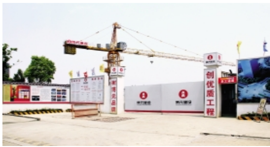
工地入口大门
