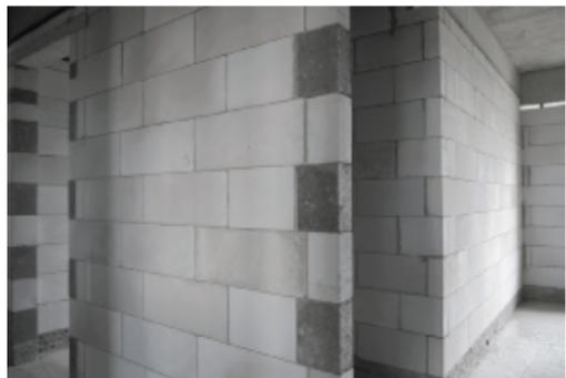
门窗洞口设置预制混凝土块
