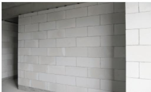
加气砌块砌体灰缝均匀饱满,缝线顺直
