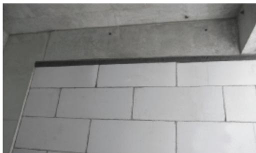
加气砌块顶塞砂浆勾缝规范,与结构连接处灰缝密实
