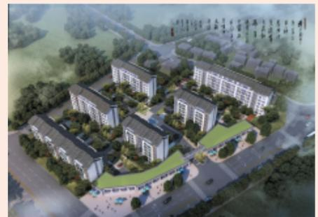
干窑镇城中村改造“棚户区”项目二期工程,位于干窑镇长生村,由嘉善县干窑镇新市镇建设投资有限公司投资兴建。总建筑面积 33483.16 平方米,建设一幢 6 层多层住宅,五幢 8 层中高层住宅,计划总工期 430 日历天。(经营二部)
