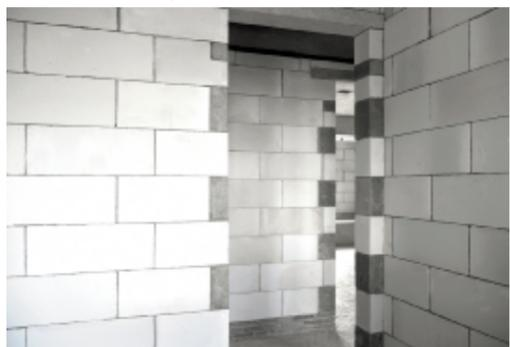
内墙加气砌块砌筑垂直平整,加气块切割大小一致
