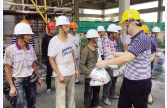
8月9日上午, 嘉兴市经济技术开发区交通建设局副局长张玮、区治安处处长李欣到我公司承建的智慧小镇项目施工现场慰问高温下作业的一线员工。
