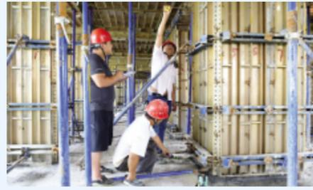
铝合金模板具有施工周期短,重复使用次数多,拼装精度高,整体浇筑成型,结构更安全稳定等一系列优点。荣盛百合花园是除海宁万科开元名都项目以外,公司第二个采用铝合金模板施工的项目。图为项目部管理人员在做浇筑前的铝模板安装质量检测。(编辑部)
