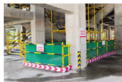
楼梯口临边防护
