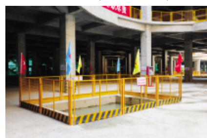
集水池临边防护
