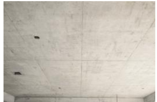
现浇底板接茬顺直
