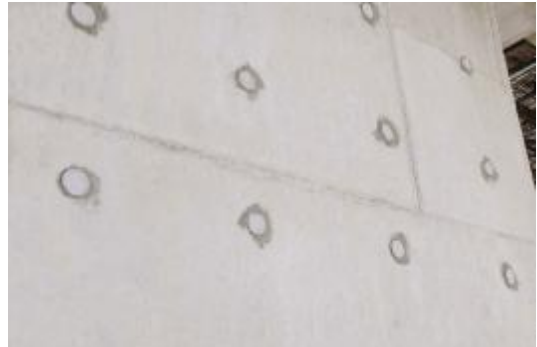
剪力墙螺杆孔洞修补工艺
