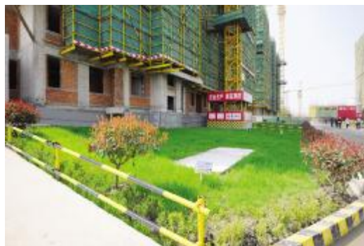
回填层绿化措施好,控制扬尘
