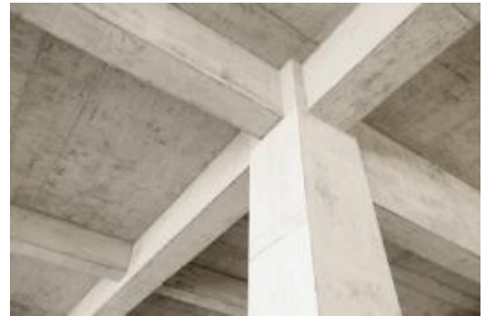
梁柱接头棱角分明,截面准确
