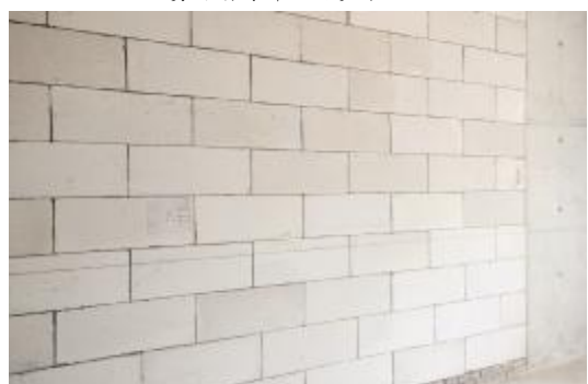
加气混凝土砌块砌筑平整度高,缝线顺直
