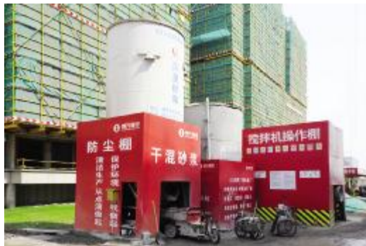
干混砂浆桶和搅拌机防护棚定型化制作
