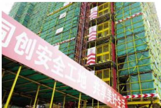
卸料平台防护措施安全有效
