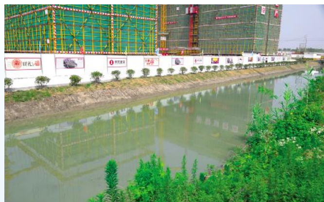
河堤用砂石土夯实,覆盖草坪,防止水土流失
