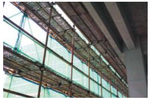
脚手片层层满铺，内封闭到位
