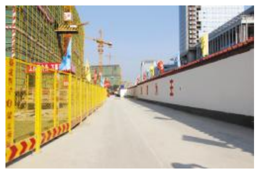
施工道路临边围护
