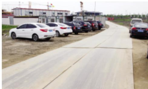
采用钢板铺设临时施工道路,有效避免因渣土清运车辆重载碾压而造成的环境污染,又节约了施工成本
