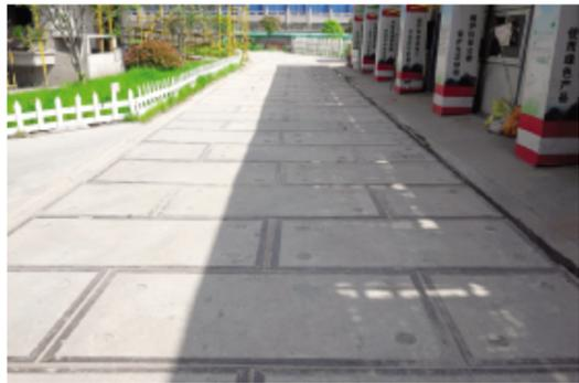
施工主干道采用预制混凝土块拼贴,实现可重复利用,降低施工成本,有效地避免了混凝土浇筑的路面因后期打裂而产生新的建筑垃圾
