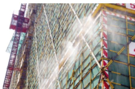
外架安装喷淋系统,控制扬尘,净化环境
