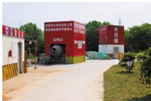
防护棚,控制扬尘
