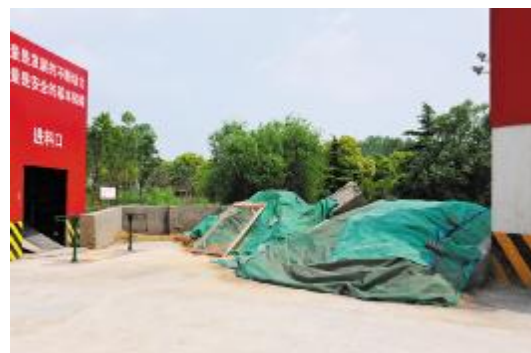
砂石堆场,完工后覆盖绿网
