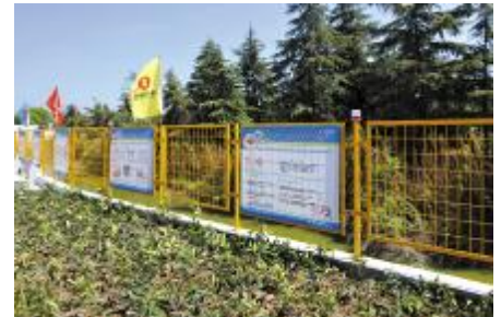
巧妙利用花坛“侧石”作挡水坡防止河道污染
