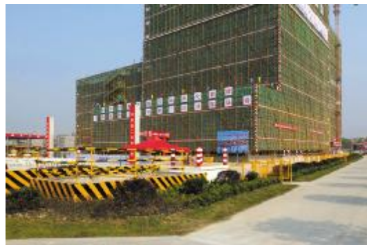
施工现场绿化
