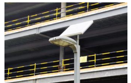
施工道路两旁安装太阳能路灯,更大幅度节约用电
