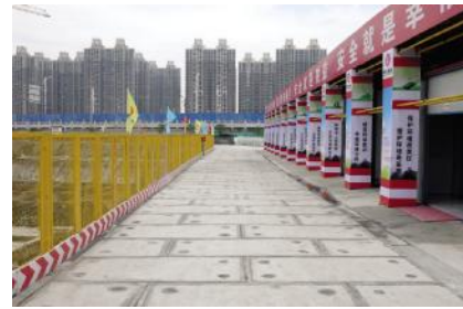
拼装式预制钢筋混凝土施工临时道路
