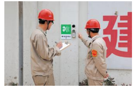
设置噪音监测点,对施工噪音进行实时监测
