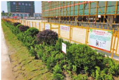
利用回填土种植绿化,有效控制扬尘
